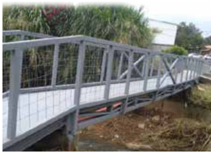
Puente peatonal sobre Río Damas en Calle Salitre en San Antonio.
