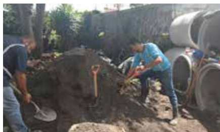
Obras de Protección fluvial en Desamparados
