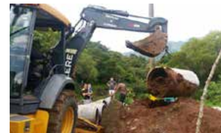
Obras de Protección fluvial en Desamparados
