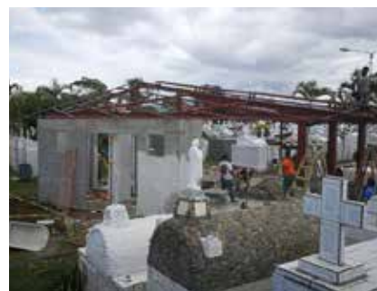
Proyecto de construcción de la Capilla Cementerio Central. ₡ 34.999.895,00.
