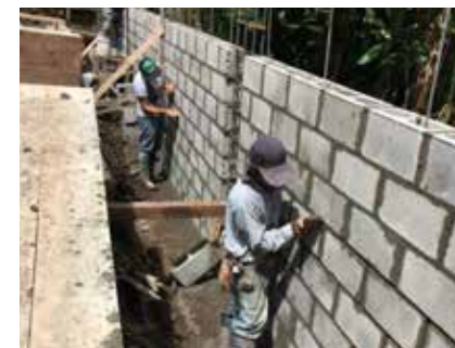
Construcción de Muro perimetral, 75 metros lineales del Cementerio San Juan de Dios.
