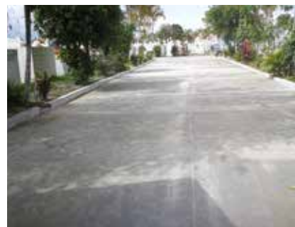
Proyecto de remodelación de la entrada sur-oeste del cementerio Central ₡ 11.128.500,00.
