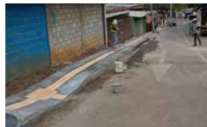
Colocación de aceras San Miguel, entrada Los Guido
