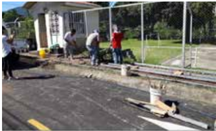
Construcción de aceras en parque Esteban Rey (Calle Fallas) €702.756,00
