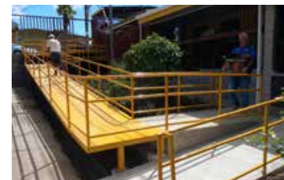
Rampas en Urbanización Mónaco San Rafael Abajo
