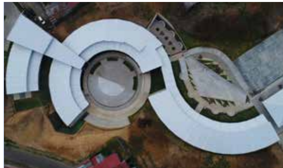
Instalaciones del Centro Cívico por la Paz
