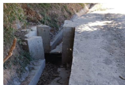
Mejoras en la red vial y canalización de aguas, Frailes, Bustamante. €7.200.000,00
