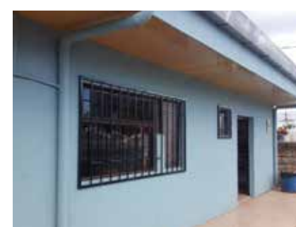
Pintura de oficinas administrativas del Cementerio Central. ₡5.225.000,00
