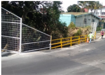
Puente vehicular sobre Río Tiribí entre Desamparados y San José
