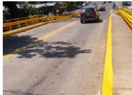
Puente vehicular sobre Río Damas, al lado de Soda Yoguis entre San Antonio y Gravilias.
