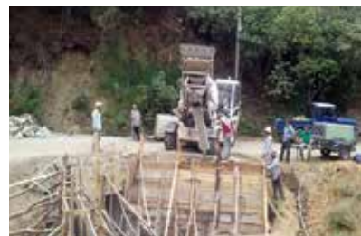
Obras de Protección fluvial en distritos del Sur
