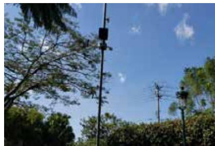
Colocación de Cámaras en San Antonio €3.598.750,00
