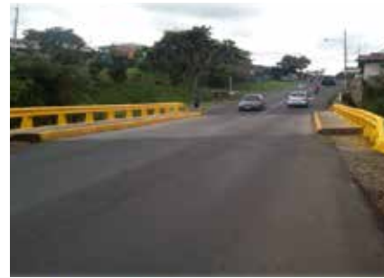
Puente vehicular sobre Río Jorco en la ruta entre Calle Fallas y San Rafael Abajo
