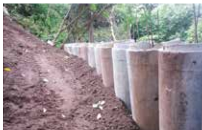
Obras de Protección fluvial en Porosales
